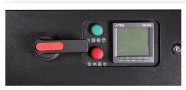
① 手柄置于分闸状态打开操作面板
